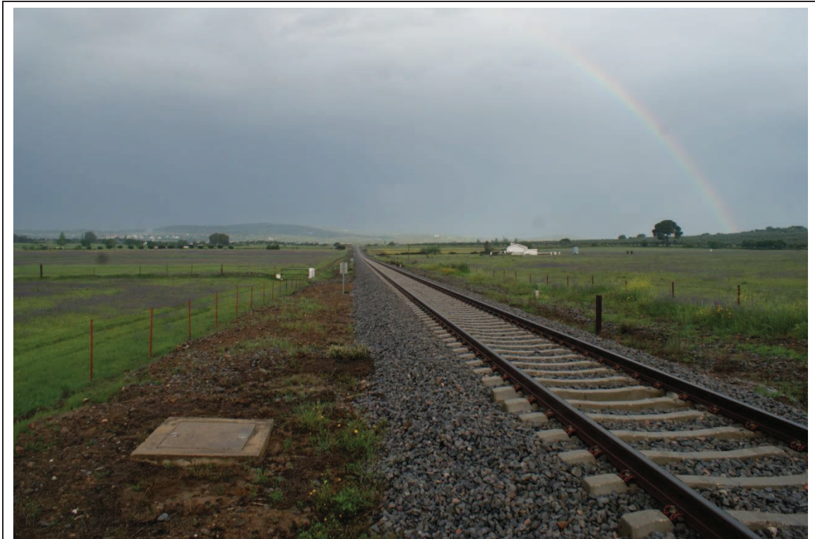
Vía del ferrocarril. Fotografía tomada de este a oeste
